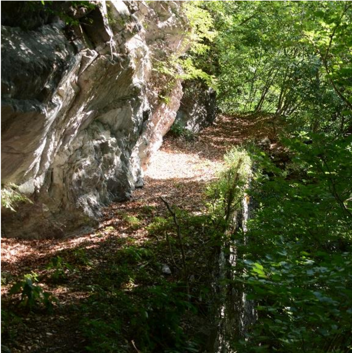
Slika 12: Detajl nekdanje ceste Gorje – Zapoškar (Foto: Damjana Čadež)
